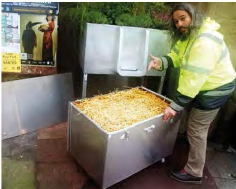
L'Uritrottoir est un urinoir sec destiné à lutter contre les pipis sauvages en zone urbaine. Les urines sont collectées dans un bac rempli d'une litière végétale qui piège les odeurs tant que les urines ne dépassent pas le niveau supérieur de la matière sèche. Une fois collecté, le produit est composté sur une plate-forme étanche.
